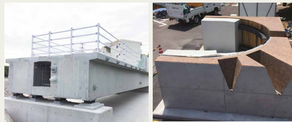
実物大のコンクリート橋モデル(写真左)。トンネルモデル(写真右)は、1980年代前半まで使われてきた「矢板工法」と、現在主流となっている「NATM法」の2つの工法を使って作られており、両者の構造の違いを比較しながら学習できる。
