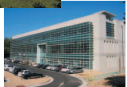
▶コンピューターセンター(建設中)
