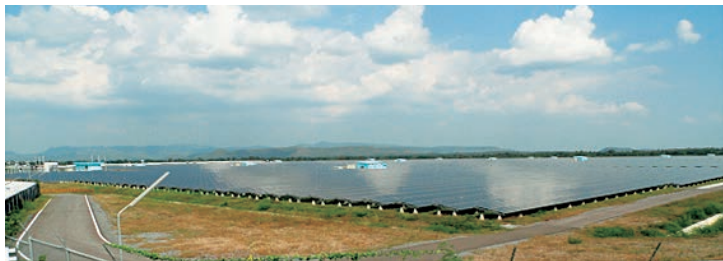
図9 ロップリー県にあるシャープ㈱が設置した84MWシステム
