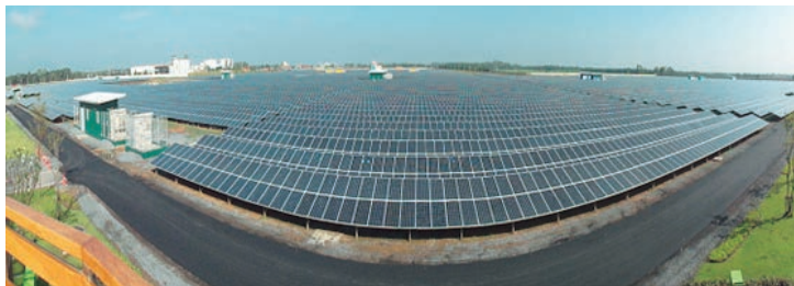
図8 洪水の被害にあったアユタヤ県にあるBangchak Solar社の44MWシステム
