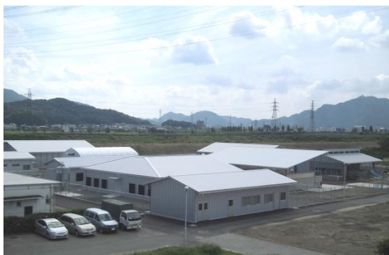
完成した実習施設
