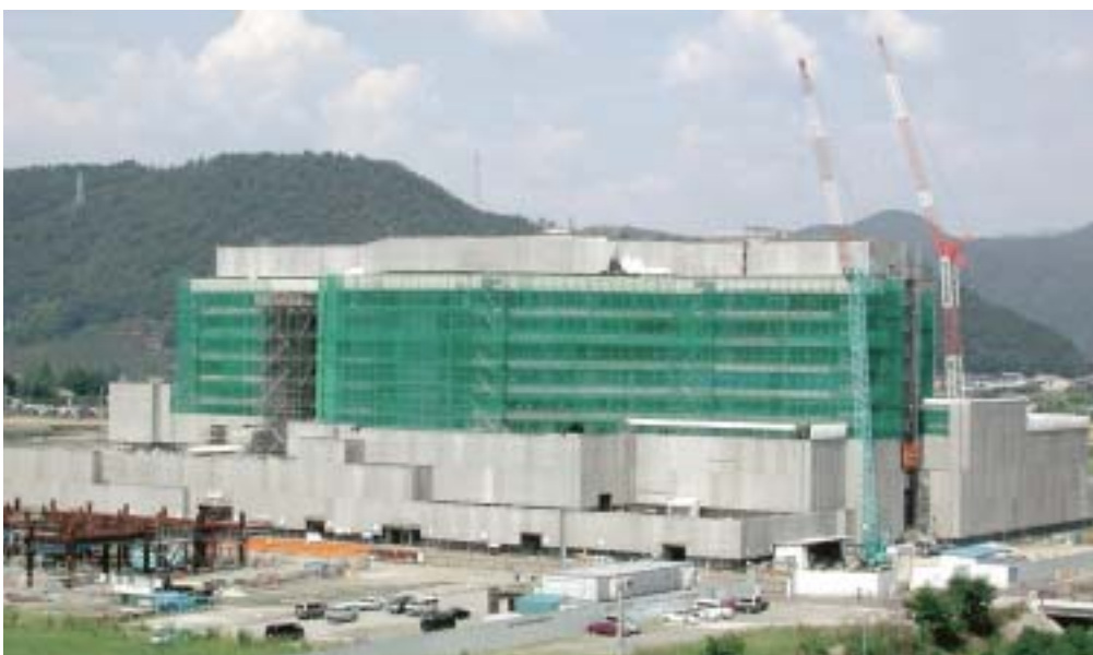
建設中の医学部附属病院 平成14年9月3日撮影
