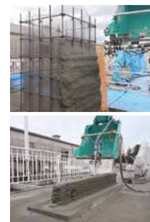
「On-Site Shot Printer」 ICTバックホーによるセメント材料の吹付け
