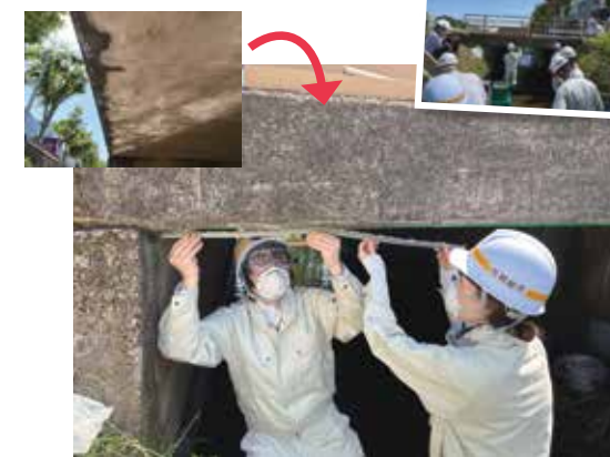
「市の職員による水切りの貼付け」 橋梁端からの水かがり跡がないか定期的に点検し、必要に応じて水切りを交換。大規模な橋は専門業者に任せ、無理のない範囲で市の職員が補修し、維持費を抑える。
