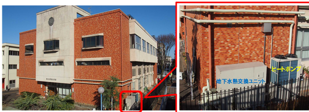
図1 岐阜市内の公民館建屋に導入したオープンループ型地中熱利用空調システム
