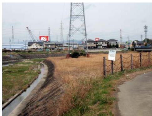
整備前の様子
