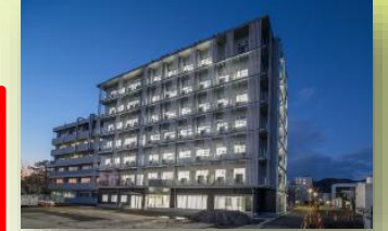
糖鎖生命コア研究所新棟 (2023年竣工)
